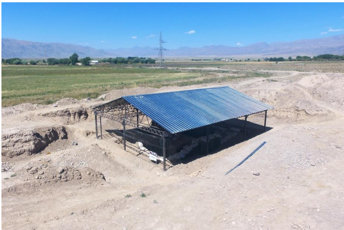
Фото 9. Металлический навес над мавзолеем Кёк-Таш.
