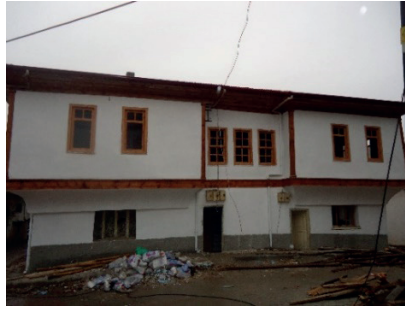
G. 51. Hasan oşkun Evi Kuzey Cephesi
