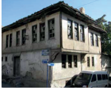
G. 27. Restorasyondan Önceki Görünümü (Çankırı Kültür Envanteri'nden)
