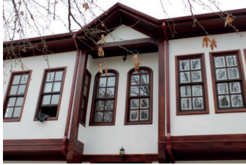
G. 38. Yaren Evi Üst Örtü Çatı ve Saçak Kısmı
