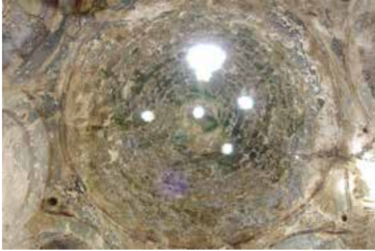
Fotoğraf 8: Beyobası Hamamı Sıcaklık Bölümü Kubbesi
