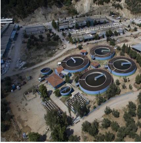
Fotoğraf 3: Arıtma Tesisi (2018)
