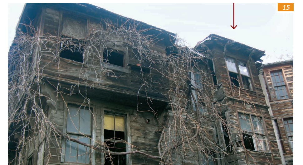
15: II. Dönem eki ahşap yapı (KUDEB, 14.12.2007)
