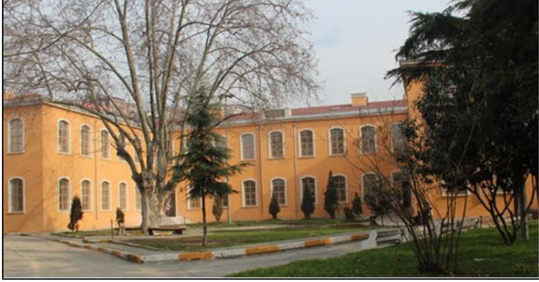
Resim 12. Hendese-i Mülkiye Mektebi için Halıcıoğlu'nda yaptırılan ve 1884'te hizmete alınan bina (Resim 10'deki C Blok) (FSMVÜ Fotoğraf Arşivi). Bu bina günümüzde Boğaziçi Köprüsü'nden geçen İstanbul Çevre Yolu (Otoyol 1, O1) üzerindeki Halici köprüsünün alt tarafında, Fatih Sultan Mehmet Vakfı Üniversitesi'nin Halici Yerleşkesi içindedir. 2010 yılında Üniversiteye devredilmeden önce bir süre Beyoğlu Adliyesi olarak da kullanılmıştır.
