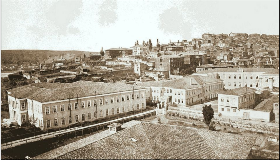
Resim 11. Mühendishâne-i Berrî-i Hümâyûn binası (solda) ile Hendese-i Mülkiye (sağda en arkada) ve ek hizmet binalarının (Hendese-i Mülkiye'nin önünde sağda ve solda) görünümü ( Osmanlı Mektepleri: Fotoğraf ve Planlar , Derl. O. Doğan, İstanbul 2007). Hendese-i
