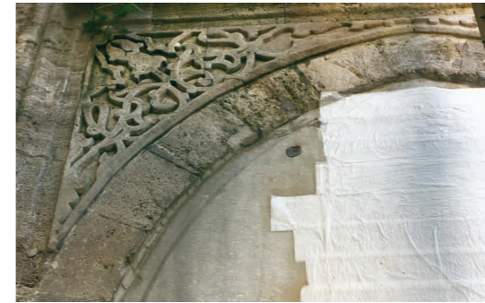
F.15: Mermer üzerinde AB57 uygulaması (KUDEB Rest. ve Kons. Lab., 2009)
