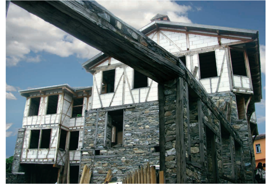
Şekil 1. Tarihi bir konutta özgün yapı malzemelerinin kaldırılıp yerine gazbetonun kullanıldığı restorasyon örneği
