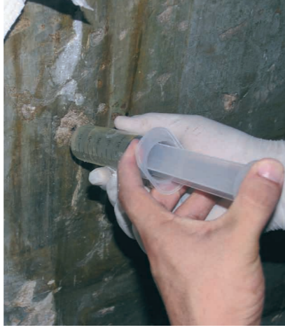
F.17: Kalem işi konservasyonu uygulaması, sıva tabakasının Paraloid B72 ile sağlanması (KUDEB Kayserili Ahmet Paşa Konagi- duvar resimlerinin konservasyonu, 2008)
