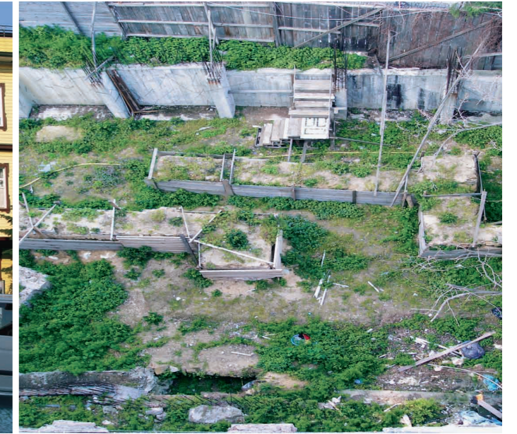
Resim 2: Obelisk Oteli Yapı Temel Kalıntıları
