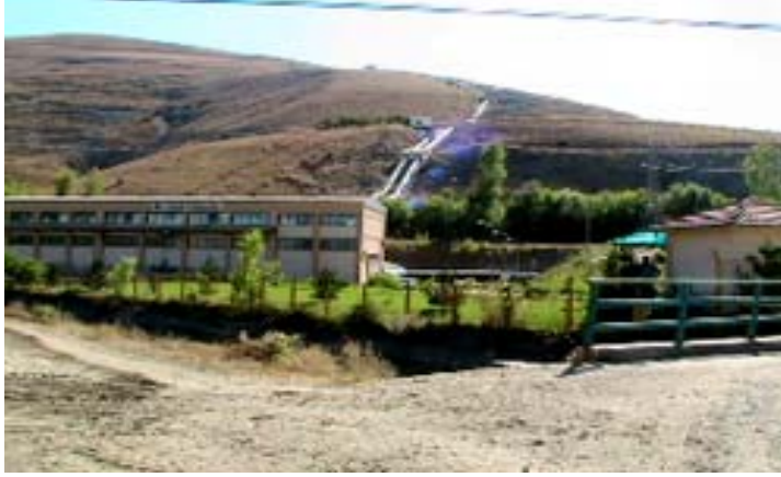
Şekil 3. Girlevik II-Mercan Hidroelektrik Santrali'nden Bir Görünüm (Erzincan'da, Karasu Irmağının kollarından Mercan deresi üzerinde yap-işlet-devret modeliyle kurulmuş olan bu nehir tipi santralden yılda ortalama 43 GWh elektrik üretilmektedir).
