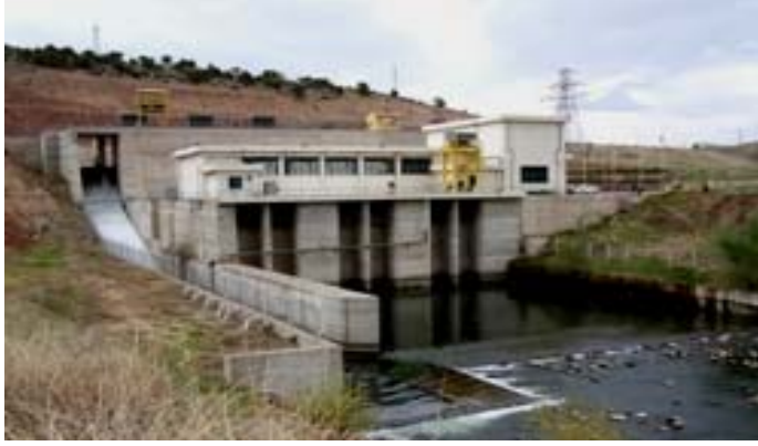
Şekil 5. Sakarya Irmağı Üzerinde Kurulu Nehir Tipi Santrallerden Beyköy HES.
