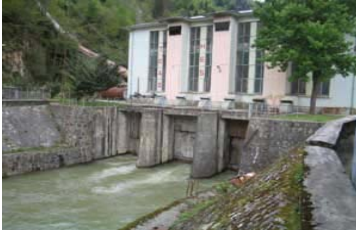
Şekil 4. İkizdere Hidroelektrik Santrali (Doğu Karadeniz Havzası ırmaklarından İkizdere üzerinde kurulu santral, her biri 6.2 MW gücünde üç üniteden oluşur. Santralden yılda ortalama 110 GWh elektrik üretilmektedir).
