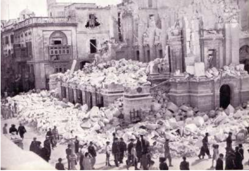
Resim 3: Hava saldırısında hasar gören Opera Evi-Valletta 42
