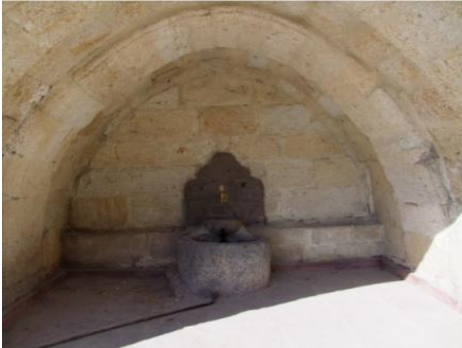
Resim 11: Musa Efendi Çeşmesi eyvan şeklindeki doğu cephesi
