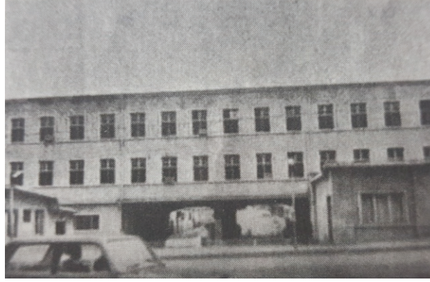
Şekil 3.4. Yönetim Binası (Zeybekoğlu, 2009)
