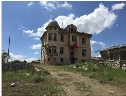
Şekil 5. Mehmet Ağa Konağı'nın Güncel Durumu (2017) [14]
