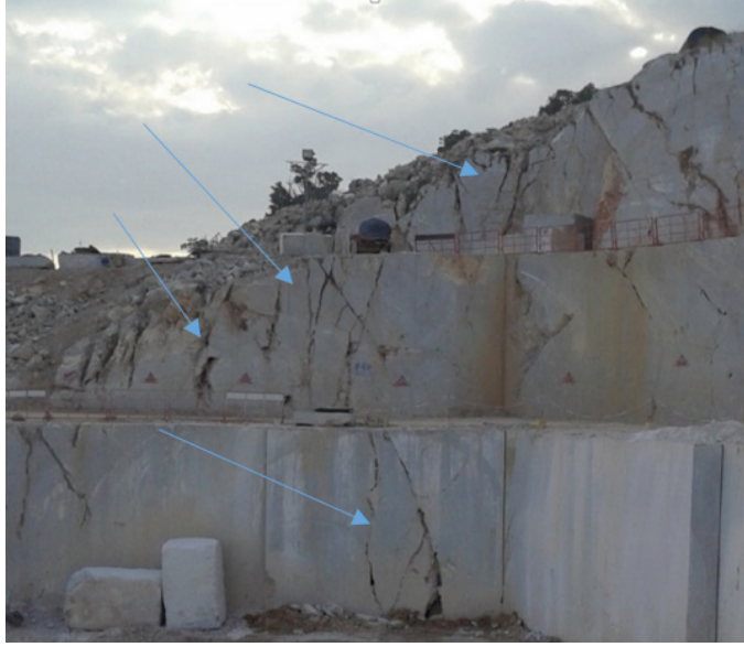
Şekil 6. Ocak kademelerinde görülen kırık - çatlak sistemleri
