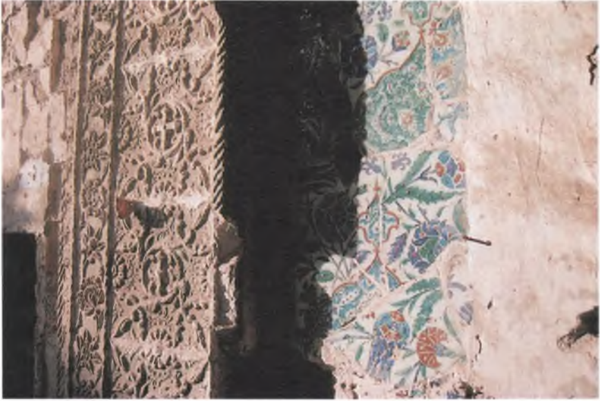
Resim 21 – Diyarbakır Ermeni Katolik Kilisesi kuzey apsisinin solundaki mekanda yer alan çiniler.
