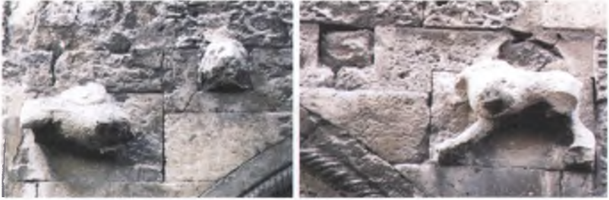
Resim:3 Portalin Kuzey köşeliğindeki Bezemeler Resim:4 Portalin Güney köşeliğindeki Bezemeler
