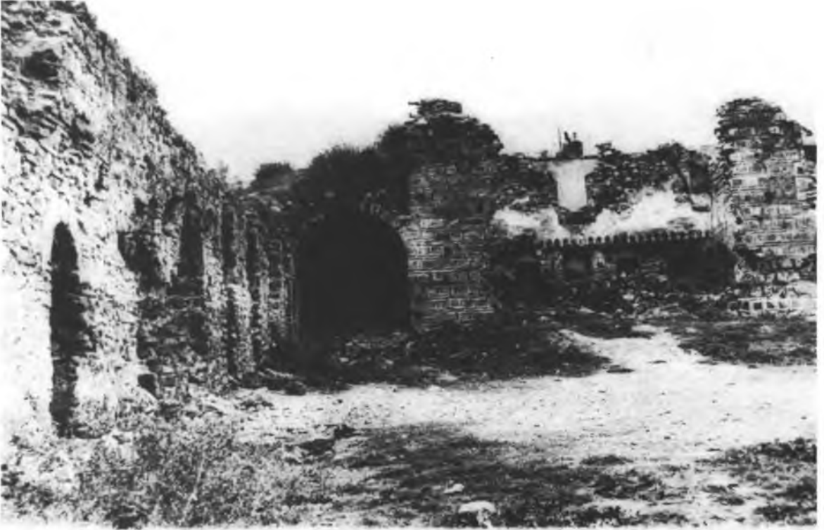
Resim 6 — Yıldırım Külliyesi darüşşifada güney-batı köşe.
