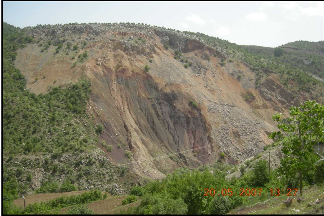
Foto 10. Recep (Bulam) Çayı vadisinde Aksu köyü civarında vadinin güney yamacında meydana gelen aktüel heyelanlardan biri. Heyelanın meydana gelmesinde killi seriler ve akarsuyun yatağını derinlemesine aşındırması etkili olmuştur. Bu heyelan Recep vadisindeki taraça üzerinde bulunan meyve bahçelerini ortadan kaldırmıştır.
