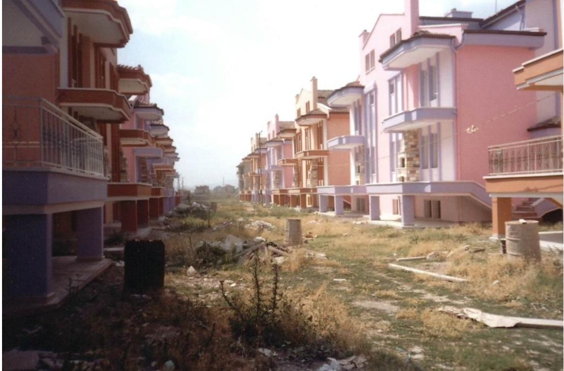
Fotoğraf 4. Çalışma alanında jeolojik yapı kat sayısına sınırlama getirmiştir. Fotoğrafta uydu kent toplu konut alanında inşa halinde iki katlı evler görülmektedir.
