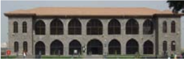
Foto. 2: Müze Teşhir Binası
