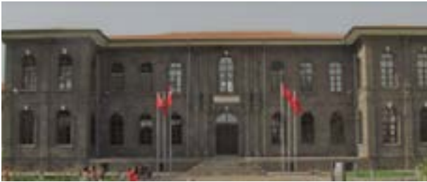
Foto. 3: Valilik Makamı (Güney cephe)
