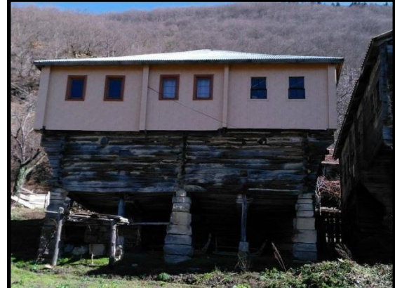
Foto 7. Oturulan bölümün ısı değerini korumak amacıyla bu bölümün naylon malzeme ile kapatıldığı bir konut (Kızılcağaya Köyü/Ayancık)
