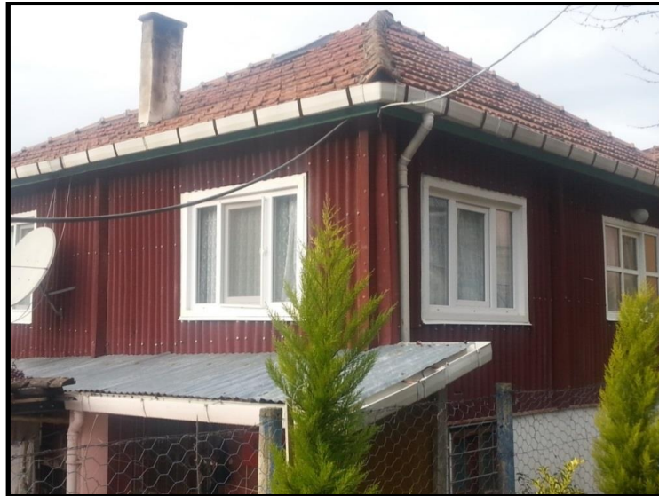
Foto 3. Ahşap evlerde pencere elemanı olarak PVC sistemin kullanımı (Yenigüler Köyü-Ayancık)
