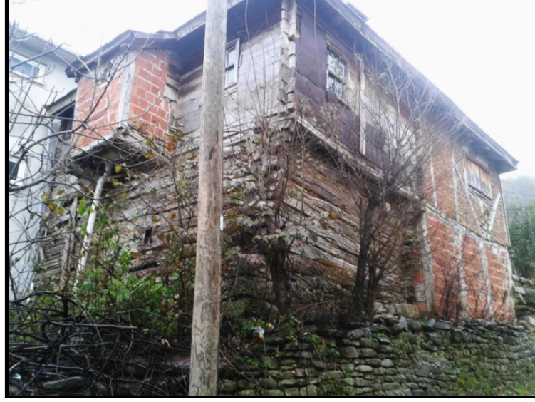
Foto 21. Konutlarda ahşap malzeme üzerine yapılan tuvalet ve banyo gibi eklemeler yapı statüğünü olumsuz etkilemektedir (Pazarcık Köyü/Ayancık).
