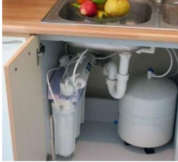
Şekil 15. 3 kartuşlu cihazın evye altına yerleşimi [16]
