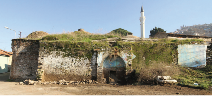
Fot. 8: Restorasyon öncesi batı cephesi. (Fot.: M. Yasa)
