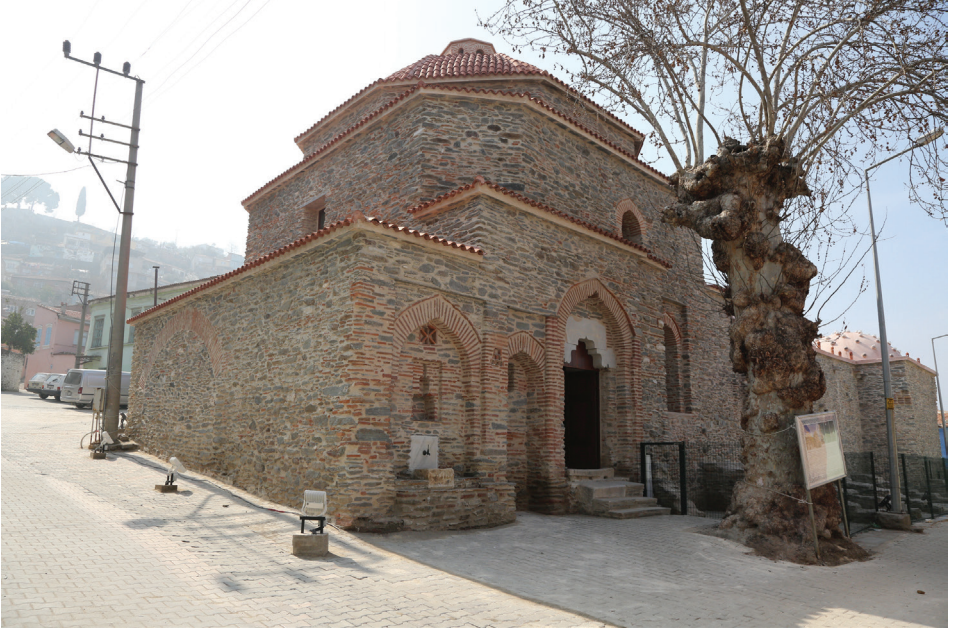
Fot. 2: Restorasyon sonrası erkekler kısmı soyunmalıđı. (Fot.: M. Yasa)
