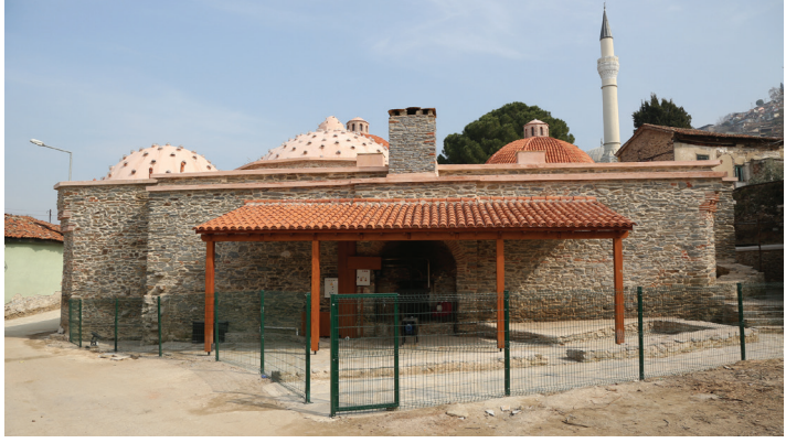
Fot. 12: Restorasyon sonrası batı cephesi. (Fot.: M. Yasa)
