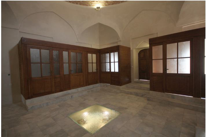
Fot. 14: Restorasyon sonrası kadınlar kısmı soyunmalığı. (Fot.: M. Yasa)
