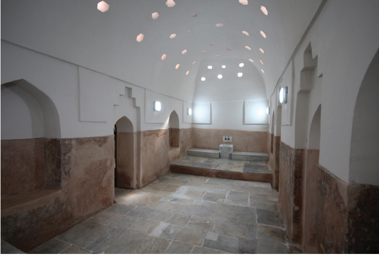
Fot. 7: Restorasyon sonrası kadınlar kısmı sıcaklığı. (Fot.: M. Yasa)
