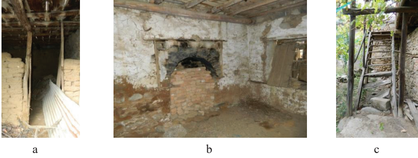
Fot. 24: Evin zemin kat odaları; kerpiç duvar (a), odadaki ocak (b) ve üst kata çıkan merdiven (c).
