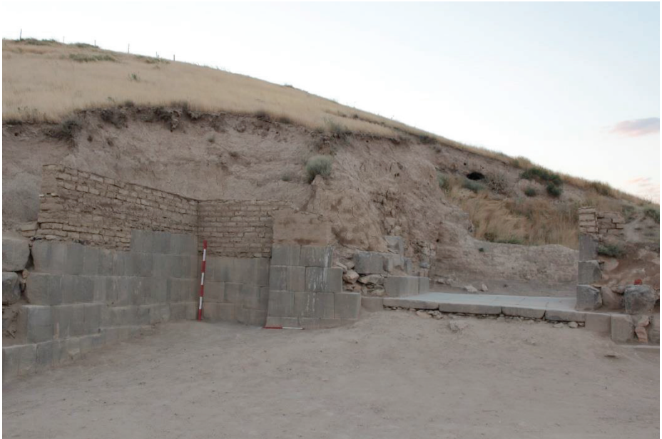
Foto. 2: Güney Sur-Anıtsal Kapı Koruma-Onarım Çalışmalarından Sonraki Hali
