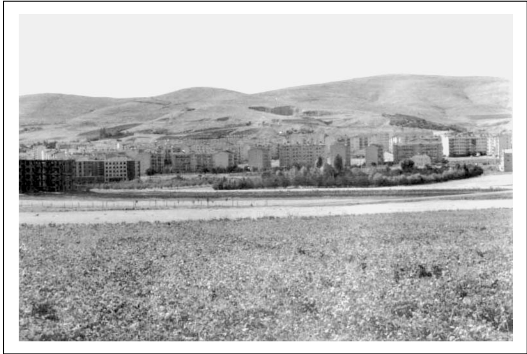
Foto.7. Elazığ-Malatya yolu üzerinde toplu konut uygulamasıyla gelişen Abdullahpaşa Mahallesi
