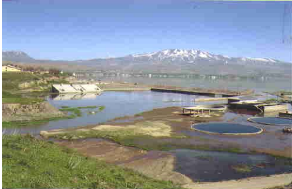
Foto 3. Tatvan'da Göl Suyu İçerisinde Kalan Atıksu Arıtma Tesisi
