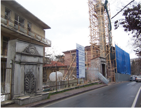
Resim 7. Bezm-i Alem Vakıf Guraba Külliyesi 'nde 2007'de çeşme ve cami onarımı. (H.Turhan Arş.)
