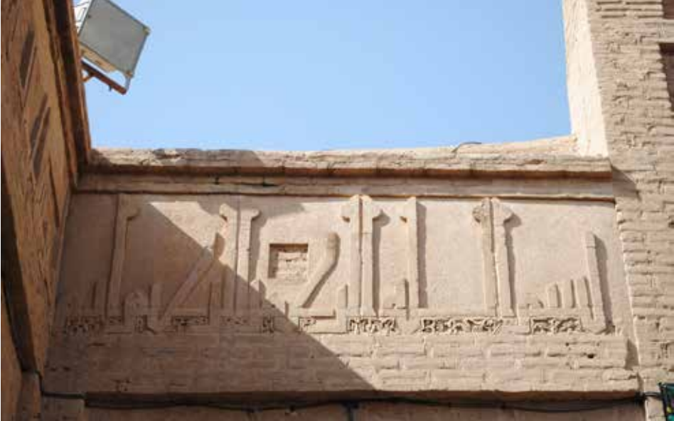
Resim 10. Zevvare Mescid-i Cuması, avlu cephesi / İran 2012
