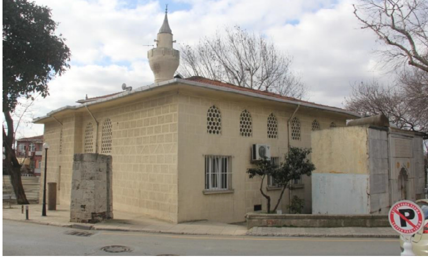
Şekil 14. İmrahor Cami Güneydoğu ve Kuzeydoğu Cephesi, (Hora Yapı Arşivi)
