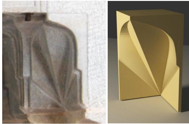
Şekil 4: Bursa Muradiye Camii'nin Taçkapısının Mihrabiyesinde Kanatlı Badem Hücresi ve 3D Çizimi.
