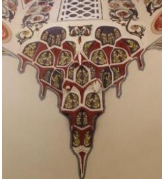
Şekil 23: Bursa Yeşil Camii'nin Sağ Yan Odanın Kubbesinin Geçişlerinde Tipik Osmanlı Mukarnas Örneği.
