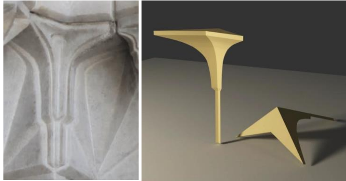
Şekil 10: Bursa Yeşil Camii'nin Taçkapısının Mihrabiyesinde Büyük İki Ayaklı Formlu Kademeli Ara Elemanı ve 3D Çizimi.
