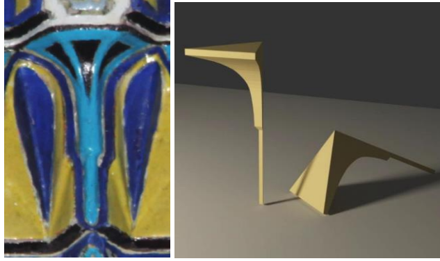
Şekil 9: Bursa Muradiye Camii'nin bir Konsolunda İkizkenar Uçgen Formlu Kademeli Ara Elemanı ve 3D Çizimi.
