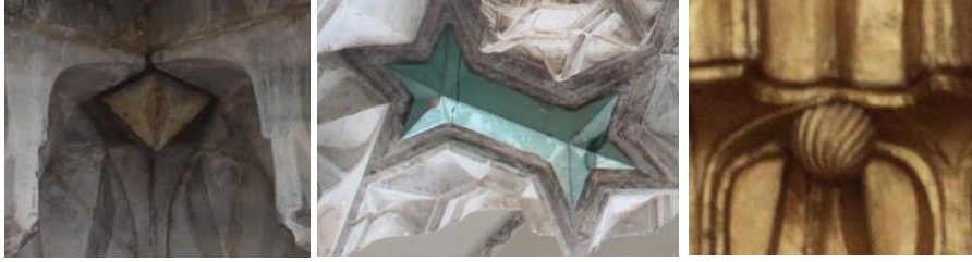
Şekil 12: Tipik Osmanlı Mukarnasının Bazı Kabartma Çeşitleri, Soldan Sırayla: Beş Köşeli Yıldız, Birleşmiş İki Yıldız Bursa Yıldırım Camii'nin Son Cemaat Mihrabındaki Örneği ve Bumalı Top Bursa Orhan Gazi Camii'nin Ana Mihrabındaki Örneği.
