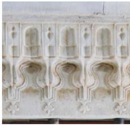
Şekil 18: Bursa Yeşil Camii'nin bir Penceresinde Göbekli Ara Elemanın Örneği.
