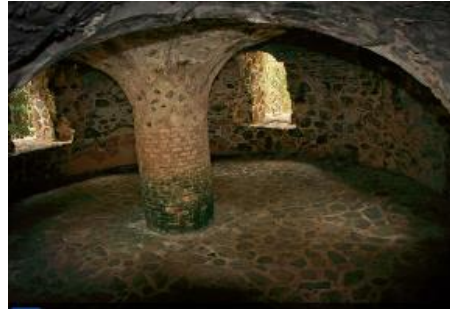
Şekil 15. Batı Hint Adalarında Bulunan Üç Dikey Silindirli Yel Değirmeninin Mahzeni. Kaynakta Tuğla Kemerlerden Bahsedilmekte Ancak Fotoğraftaki (The Westindian Heritage, 2017), Basık Kemerin Taş Olduğu Görülmektedir.
