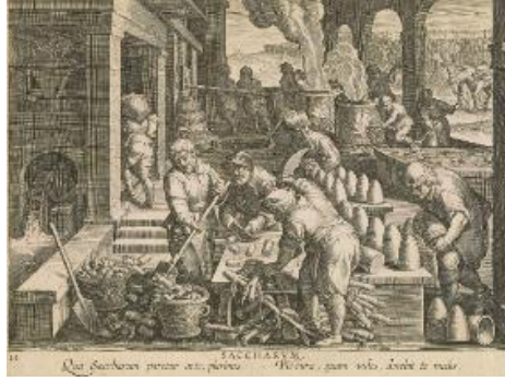
Şekil 5. Sicilya’da Su Gücüyle Çalışan Geleneksel Değirmende Şeker Üretimini Gösteren Tasvir, 16. Yüzyıl (Straet & Galle, 1590: 13), (Crowley, 2016: 410).
