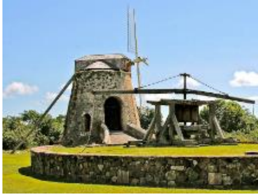
Şekil 12. Önde Dairesel Bir Platform Üzerine Kurulmuş Hayvan Gücüyle Çalışan Şeker Değirmeni ile Arkada Rüzgâr Gücüyle Çalışan Yel Değirmeni Yer Almaktadır; Batı Hint Adaları (The Westindian Heritage, 2017).
