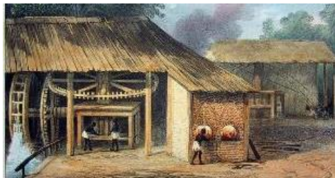
Şekil 18. Görselde, Önde Su Gücüyle Çalışan, Geride Hayvan Gücüyle Çalışan Üç Dikey Silindirli Değirmen Yapıları Görülmektedir (The John Carter Brown Library, 2018).
