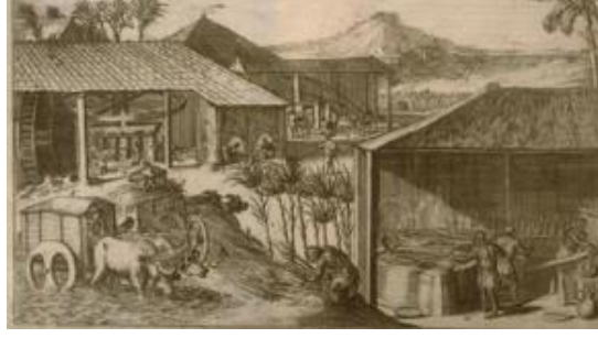
Şekil 19. Brezilya’da Şeker Üretimi, 1682, Soldaki Yapıda Su Gücü ile Çalışan, Arkadaki Yapıda da Hayvan Gücü ile Çalışan Üç Dikey Silindir Mekanizması ve Sağ Altta Kaynatma Evi Görülmektedir (Slavery Images, 2017).
