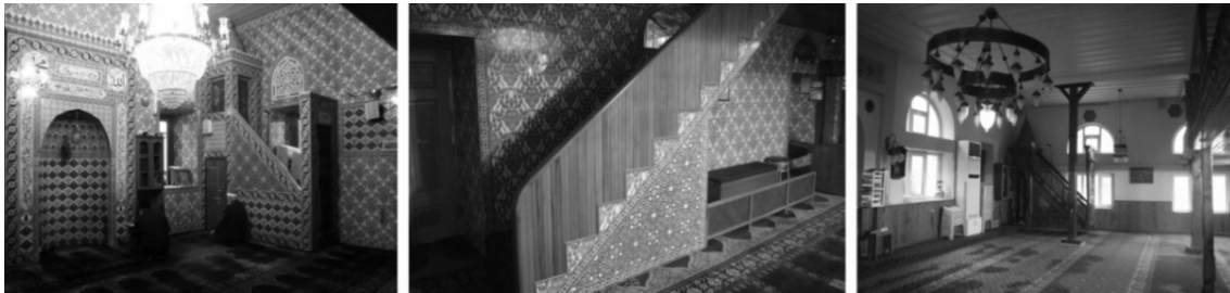
Şekil 4: İç mekan duvarlarının yeni çini veya ahşap malzeme ile kaplanması (Kaynak: Yazar, 2018)
