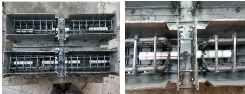
Şekil 18. Beton dökümüne hazır hale getirilmiş kalıp örneği
