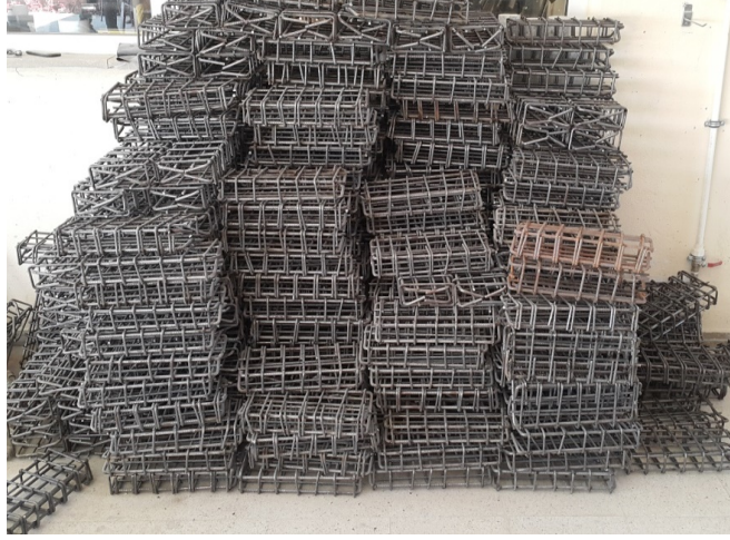
Şekil 12. Kiriş dökümüne hazır halde laboratuvara getirilen kesme donatıları
