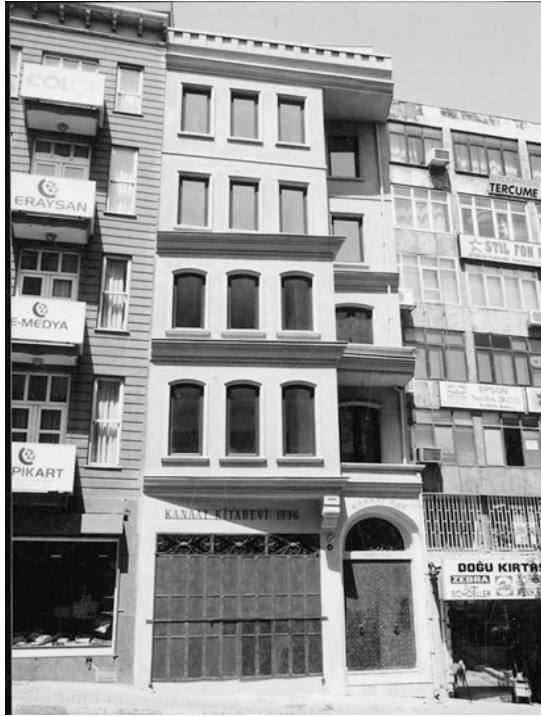
Şekil 7. Kanaat Kitabevi binası, ön cephe uygulaması (Çorapçioğlu, 2003).
