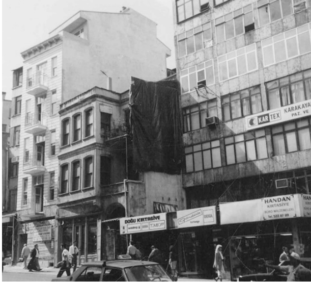
Şekil 3. Eski Kanaat Kitabevi binası (Çorapçioğlu, 2003).
