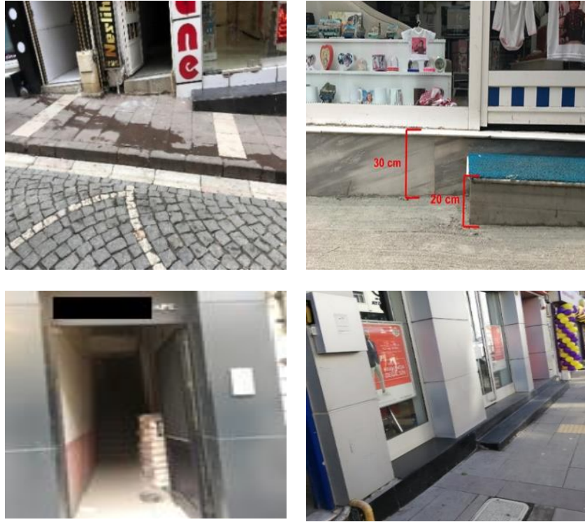
Şekil 9. Mustafa Kemal Paşa Caddesi bina girişleri (Figure 9. Building entrances on Mustafa Kemal Paşa Avenue)
