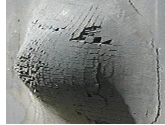
Resim 9. Bina dış cephe balistik zırhlama [82] (Photo 9. Building exterior ballistic armoring [82])
