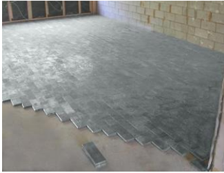
Resim 7. Kurşun tuğlalarla tabanda-zeminde zırhlama uygulaması [81] (Photo 7. Base bricks on the ground-floor armoring application [81])
