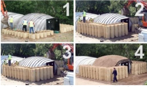
Resim 5. Beton kumaş barınak zırhlama uygulama örneği [79] (Photo 6. Concrete fabric refuge application example [79])
