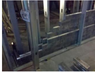
Resim 8. Kurşun tuğlalarla duvarda zırhlama uygulaması [81] (Photo 8. Armoring of wall with lead bricks [81])
