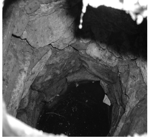
Res. 6: Altı Poğaçca camii yanında yer alan su kuyusu.
