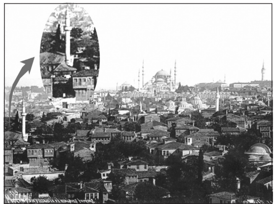
Res. 13: Altıpoğça Camii'nin eldeki tek fotoğrafı. Sağdaki kubbeli cami ise Yarhisar Camiidir. (Sebah ve Joiller, yaklaşık 1870)
