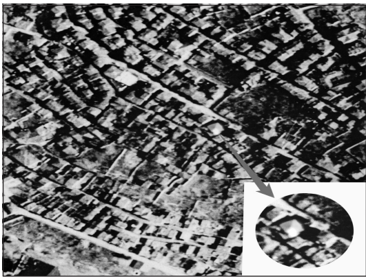
Res. 12: Altıpoğça Camii'nin yangın öncesi hava fotoğrafı (1918).
