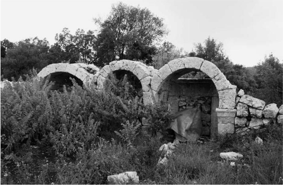
Abb. 6 Tapureli. Gebäude mit drei Tonnengewölben. In den beiden äußeren Gewölben befinden sich Türen.
