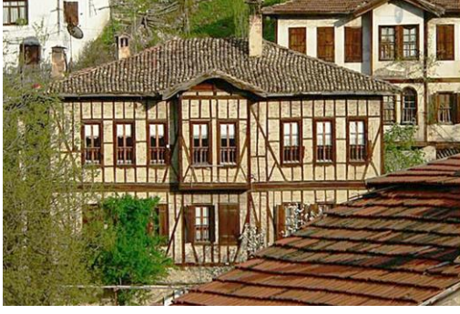
Resim 23. Geleneksel Türk Evi'nde çatı örtüsü (URL-21)
