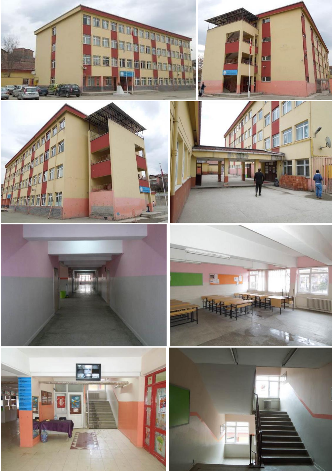
Şekil 2. Şehit Şendoğan Topçu ilkokulunun cephelerinden ve iç kısmından bazı görünüm
