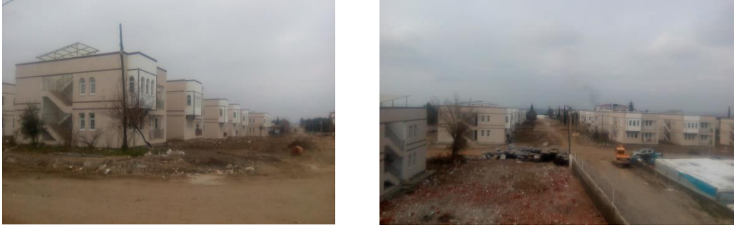
Fotoğraf 3: Depremzedelere Devlet Desteği ile İnşa Edilmekte Olan Evlerden Bir Görünüm
