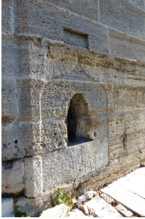
G. 4. Selimiye Külliyesi Duvar Çeşmesi Zeminde Görülen Plastik Tahliye Borusu, (N. Ç. Akçıl Harmankaya, 2018)
