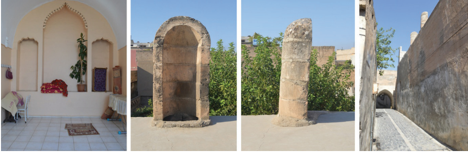
G. 10. Eyvanın arka duvarındaki hava çıkışlarının üzerinde bulunduğu sol ve sağ nişler (solda), düz çatı üzerinde bulunan rüzgâr yakalayıcıların hava giriş açıklıklarının (kuzeye ve batı yönlerine bakan) düz teras çatıdan (ortada) ve sokaktan görüntüleri (sağda) (Yahya Melikoğlu)
