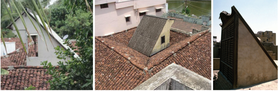
G. 6. Eğimli çatılarda tek yönden rüzgâr alan rüzgâr yakalayıcı, Nagapattinam, Hindistan (solda: Priya, Sundarraja, Radhakrishnan, 2012, s. 584, ortada: Priya, 2013, s. 60) ve Bayt Al-Suhaymi konutunun rüzgâr yakalayıcısı (malkaf), Kahire, Mısır (sağda: http://dome.mit.edu )
