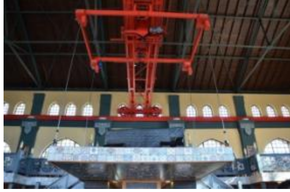
Şekil 15. Yapı içerisindeki vinç ve taşıdığı sahne [24].
