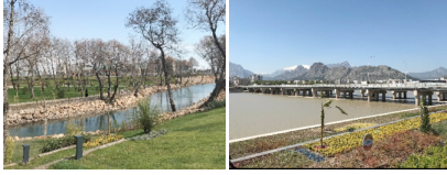
Şekil.5 Boğaçay Çevre Düzenleme Projesi ve Boğaçay Köprüsü
