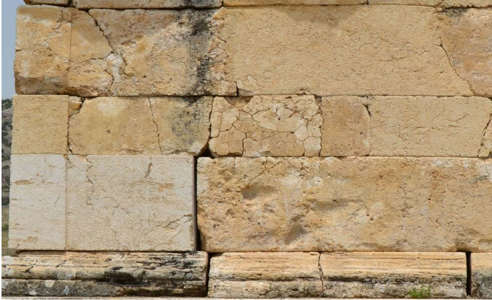
Foto. 4: Eksik bloklar yerine üretilen traverten bloklar ve çimentolu harçla örülen çift sıra duvarlar.
