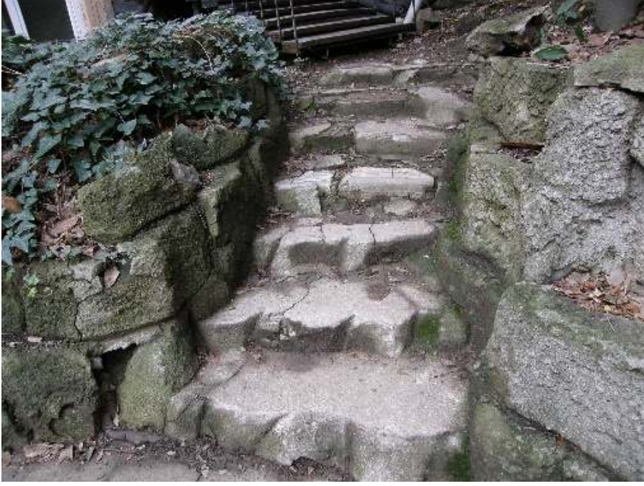
Figür 15. Bahçede kot farkının küçük olduğu yerlerden birinde kullanılan merdiven.
