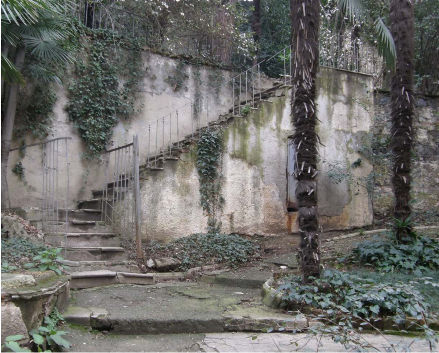
Figür 16. Bahçede kot farkının büyük olduğu yerlerden birinde kullanılan merdiven.
