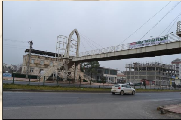
Foto 3. Şanlıurfa-Mardin Karayolu Üzerinde Yer Alan Üst Geçit 2
