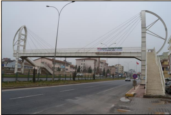
Foto 2. Şanlıurfa-Mardin Karayolu Üzerinde Yer Alan Üst Geçit 1
