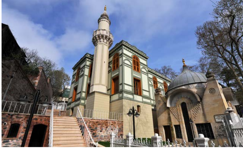
Şekil 2. Ertuğrul Tekke, Beşiktaş. Restorasyon Sonrası. 26
